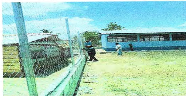
Foto 2: Reparacion de muro perimetral
