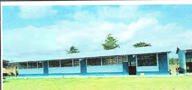
Foto 1: Cambio de lamina por lamina troquelada
